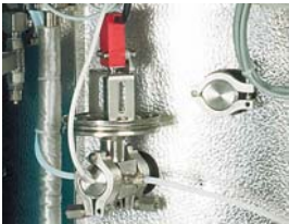
FVG - Membrane safety device for preventing lid opening even in case of minimal over pressure FVG - Dispositivo di sicurezza a membrana per evitare l'apertura del coperchio anche in case di minima sovrappressione
